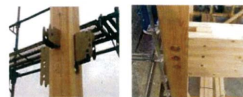
ハイブリッド工法現場施工状況
